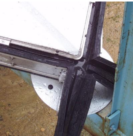
Figuur 17: Het roestvast stalen buitenpaneel is geïsoleerd van het gegalvaniseerd binnenpaneel door middel van dichtingen.
