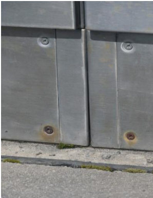
Figuur 14: Hoe kleiner het verzinkte oppervlak t.a.v. van het roestvast stalen oppervlak, hoe sterker de galvanische reactie.
