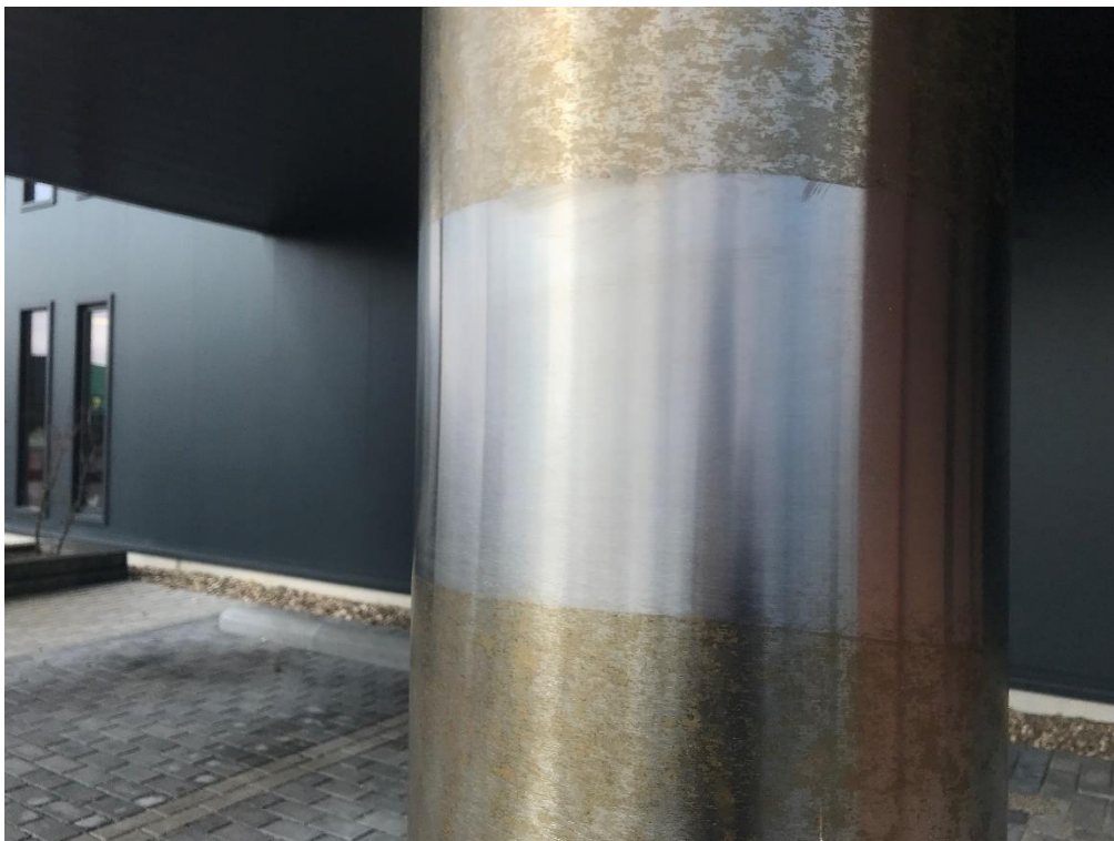
Dezelfde RVS kolom als boven echter een klein deel is behandeld
