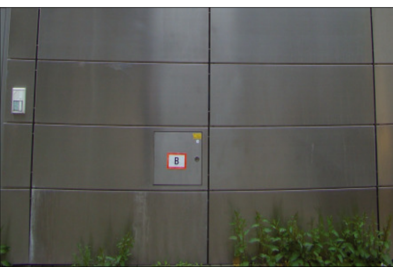
Voor buitentoepassingen of in corrosieve milieus zijn passiveren en beitsen vaak ontoereikend met enorme corrosieproblemen tot gevolg
