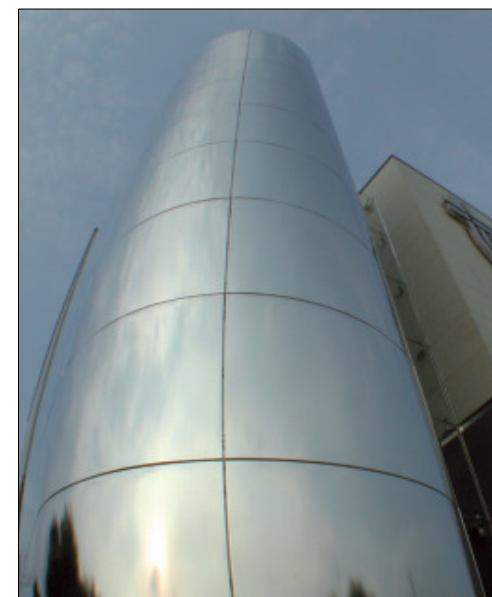
Elektrolytisch polijsten zorgt voor een glanzend uiterlijk in combinatie met een sterk verbeterde corrosieweerstand
