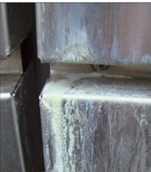
In spleten kan vuil zich makkelijk opstapelen en invreten in het materiaal, wat nefaste gevolgen heeft voor rvs
