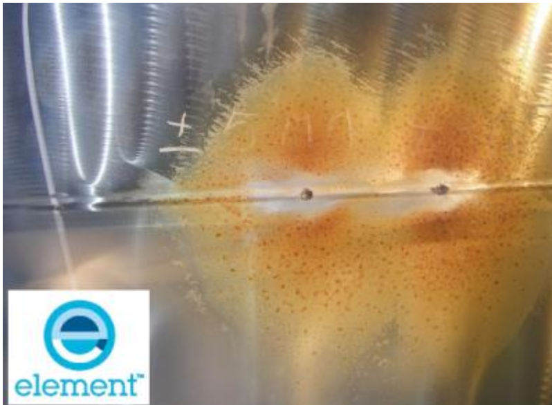
Figuur 1. Links: kleine, visueel nauwelijks zichtbare defecten aan het lasoppervlak hebben geleid tot putcorrosie van een las in een 316L roestvast stalen vat. De corrosieproducten hebben zich verspreid, de donkere puntjes op de wand zelf wijzen reeds in de richting van startende putcorrosie op de wand.
