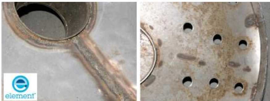
Figuur 3. Aanloopkleuren met beginnende aantasting langs de lassen aan het inwendige van een type 304L roestvast stalen watertank.
