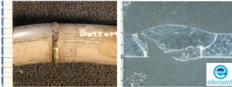
Figuur 2. De corrosievastheid van een lasverbinding wordt onder meer beïnvloed door de samenstelling van het lasmetaal. De linker foto toont een TP316L koelleiding waar binnen een jaar gebruik galvanische aantasting van het lasmetaal is opgetreden als gevolg van plaatselijk gebruik van een verkeerde las electrode (ongelegeerd staal). De rechter foto toont de doorsnede van de aangetaste lasverbinding.
