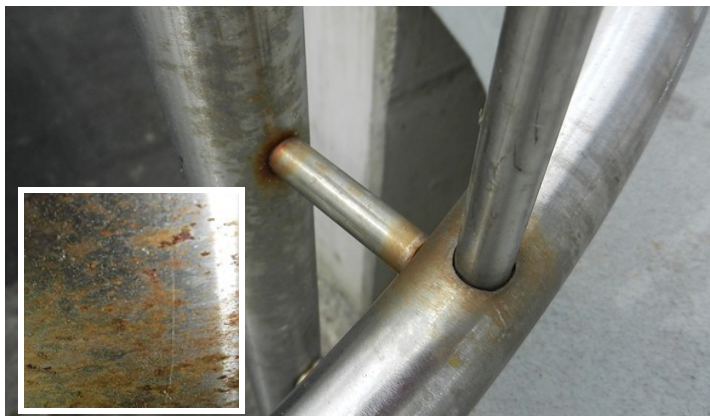
Het roesten treedt des te sneller op waar de chroomoxidehuid beschadigd is
